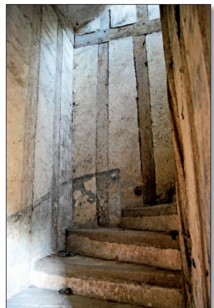
219. Accès aux étages : l'escalier et le colombage de la Maison-Forte. (09-2011/Photo Déhel)
