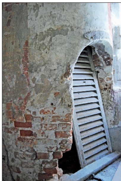
218. Le grand manteau de briques couvrant le puits à l'intérieur du Vieux Château. Un grand volet de protection a été rapporté pour masquer l'ouverture dangereuse. (09-2010/Photo Déhel)
