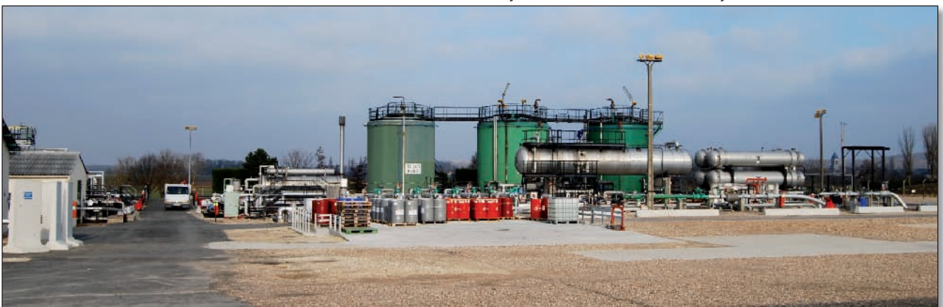
655. Les installations Total E&P France, site de Vert-le-Grand. (01-2011/Photo Déhel)
