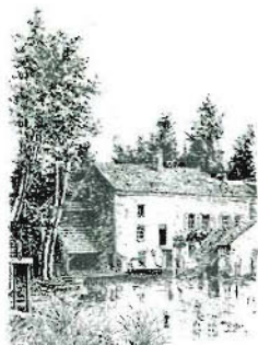
Bagneux-sur-Loing Le Moulin Portonville
